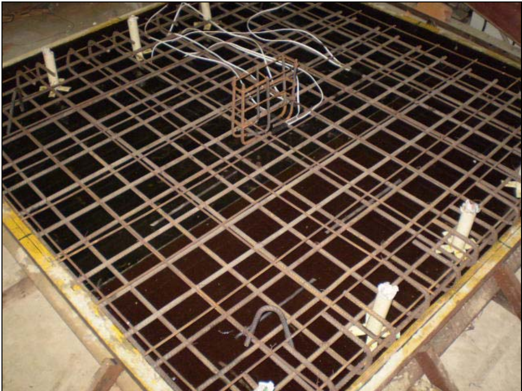
Figura 3.6 – Armaduras da laje L2B posicionada na fôrma
