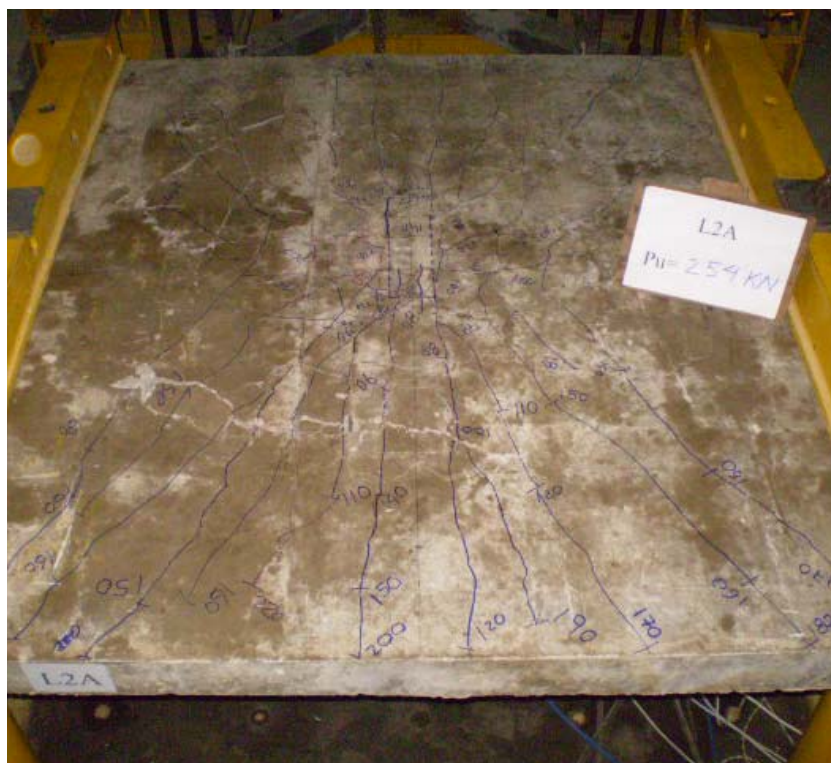
Figura 4.61 – Mapa de fissuração da laje L2A
