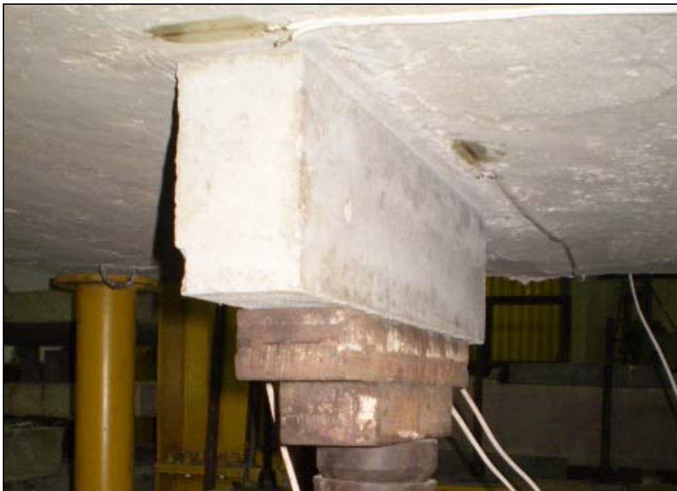
Figura 3.15 – Instalação de extensômetros na superfície do concreto da laje L4A
