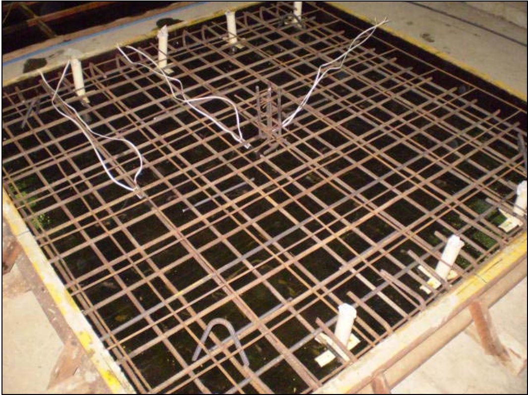
Figura 3.5 – Armaduras da laje L1A posicionada na fôrma
