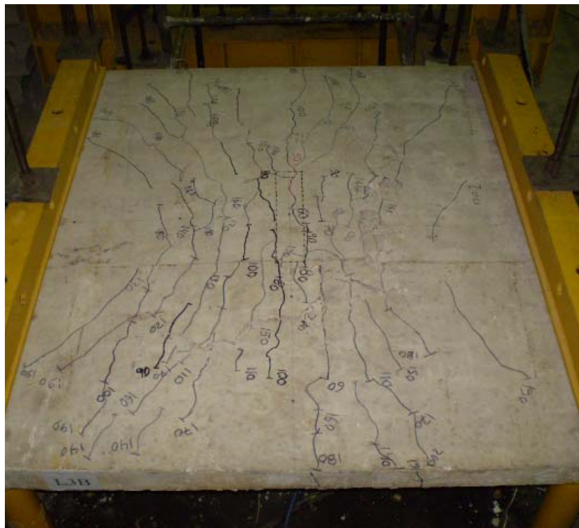
Figura 4.64 – Mapa de fissuração da laje L3B
