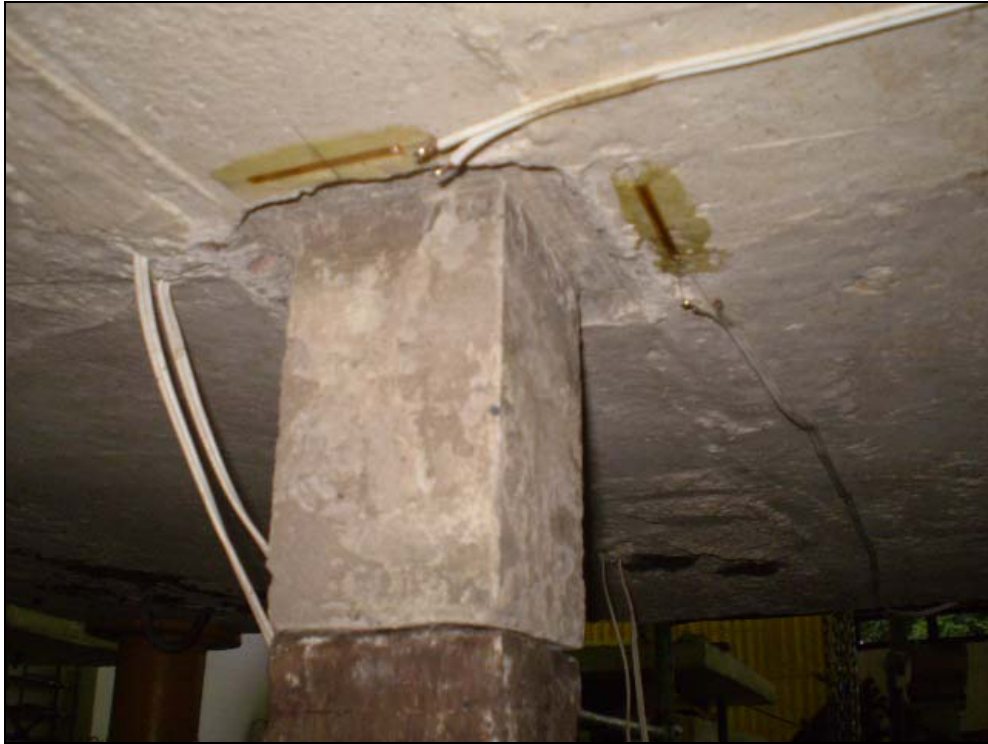
Figura 3.14 – Instalação de extensômetros na superfície do concreto da laje L1A
