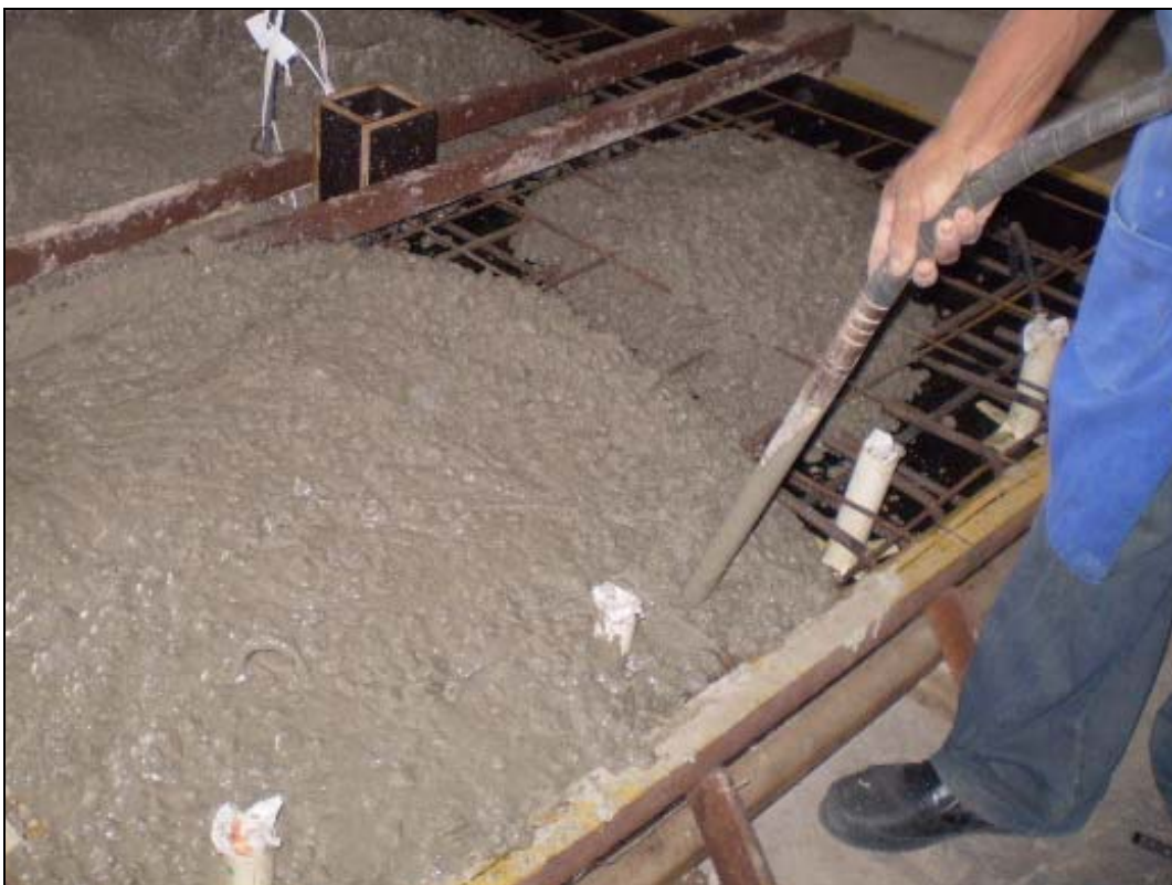
Figura 3.33 – Procedimento de vibração do concreto efetuado nas lajes
