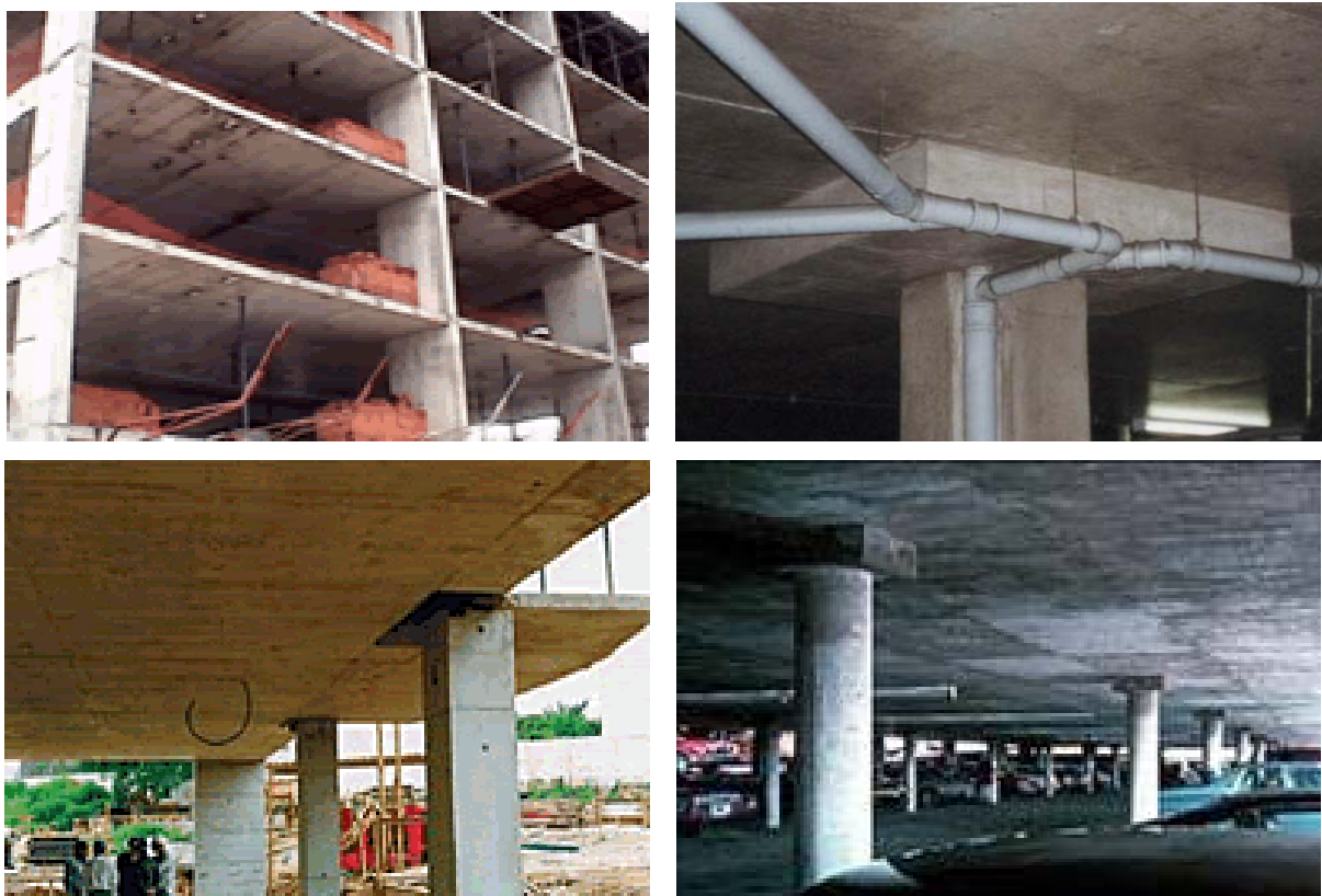
Figura 1.3 – Sistemas estruturais em lajes lisas (esquerda) e cogumelo (direita)
