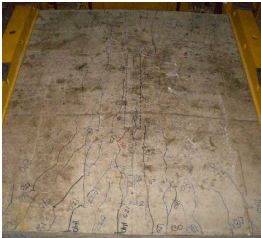
Figura 4.65 – Mapa de fissuração da laje L4A
